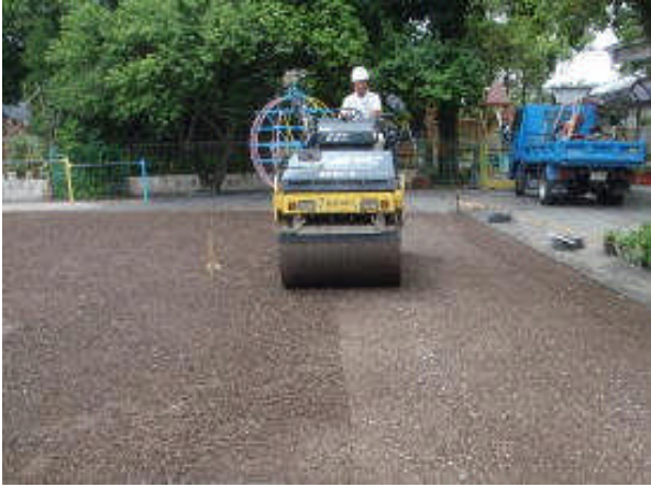
写真 7：転圧にはロードローラ使用 小型現場ではサイドローラや 振動コンパクトも使用します
