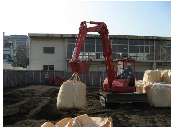
0.25m 3 以上のバックホーを使って荷下ろし、掃き出しをおこなってください。
