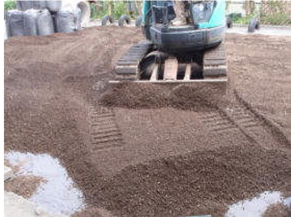
写真 4 : バックホウによる敷込み
