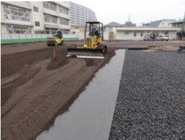
写真 5 : 大型現場ではストレートドーザ使用
