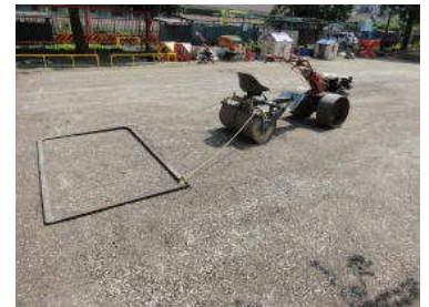
写真 6 テーラーや木枠を使用して不陸調整する
