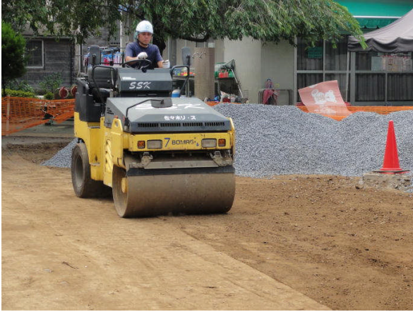
写真 1 : 既存土壌転圧
