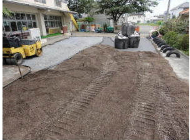
写真 8：グラスミックスの走行路は大型車も乗り入れ可能に
